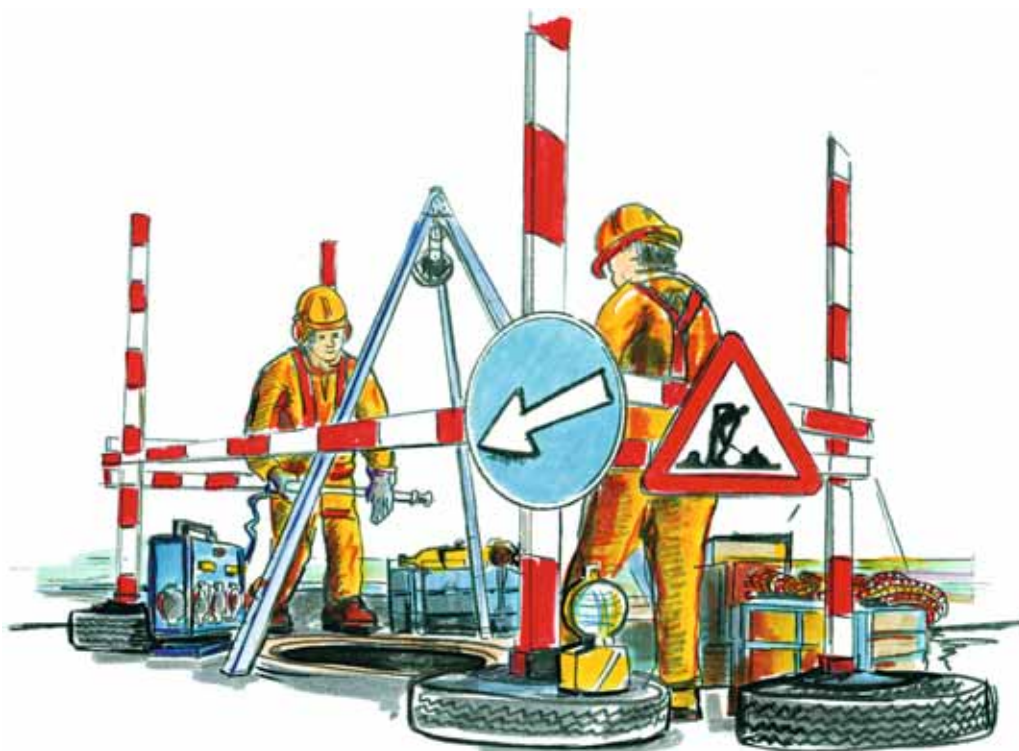
Figura 4: sbarramento e segnalazione della zona di lavoro.
