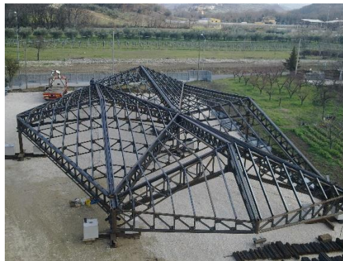
Foto della struttura metallica realizzata
