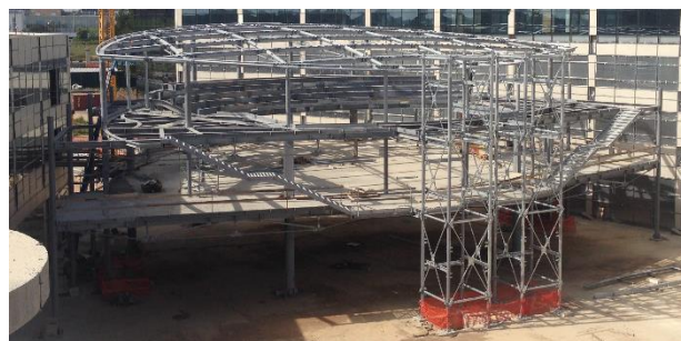
Foto della struttura metallica dell'aula consigliare realizzata
