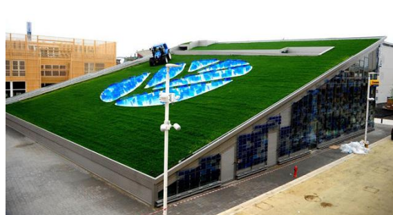
Foto della struttura completata
