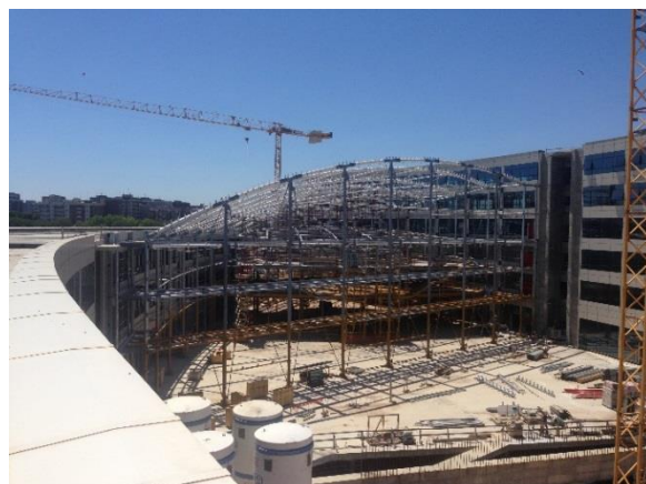
Foto della struttura metallica del Foyer realizzata
