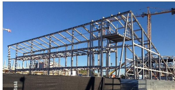
Foto della struttura in acciaio realizzata
