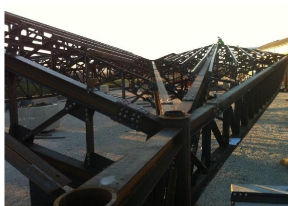
Foto del nodo strutturale realizzato
