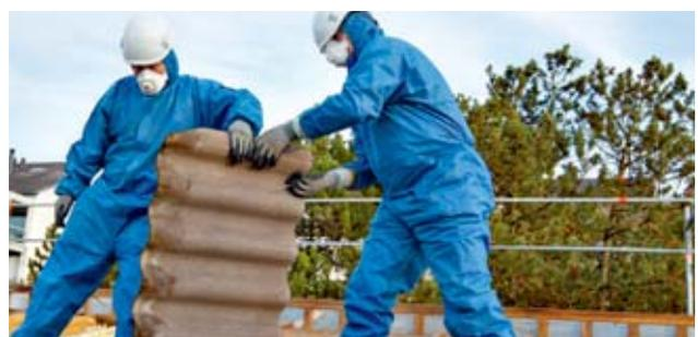
2 In caso di demolizione è vietato frantumare le lastre in fibrocemento.
