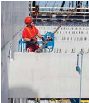
Regola 2 Utilizzare i punti di ancoraggio.
