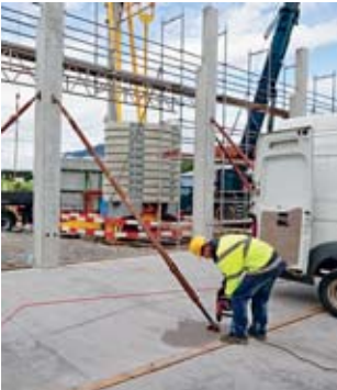
Regola 7 Stabilizzare i componenti.
