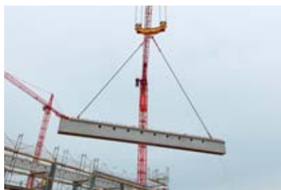
2 Imbracare correttamente i carichi asimmetrici.
