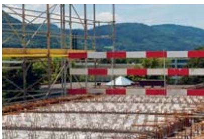
2 Preassemblare la protezione laterale.
