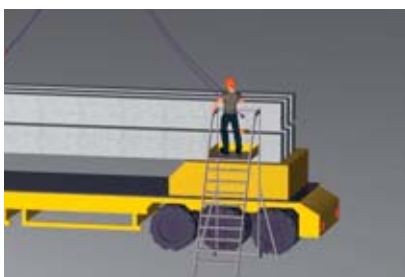
2 In caso di aggancio e sgancio da oltre 2 m di altezza, utilizzare mezzi ausiliari, accessori di imbracatura lunghi oppure DPI anticaduta.
