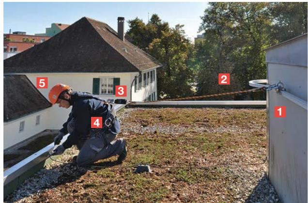
Fig. 11 Sistema di trattenuta su un tetto piano
