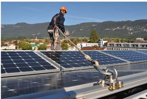
Fig. 9 Sistema di trattenuta
