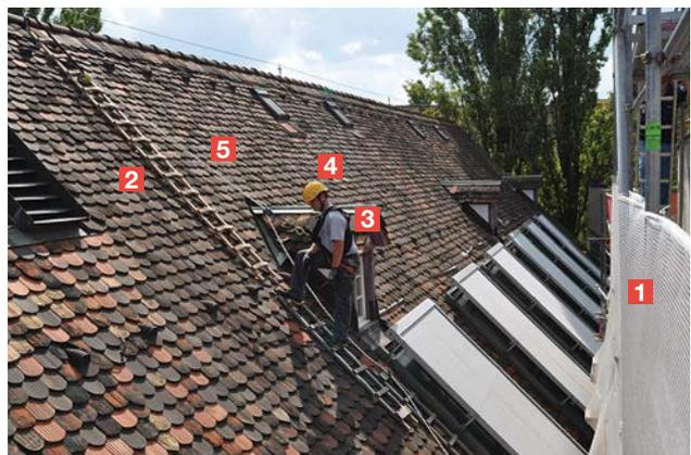
Fig. 12 Sistema di posizionamento sul luogo di lavoro su un tetto inclinato
