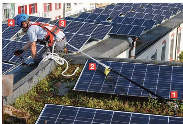
Fig. 13 Sistema di arresto caduta (ritenuta)
