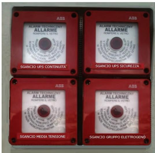
Tali dispositivi di emergenza permettono di sezionare i circuiti a monte dell'autorimessa e consentono di:
